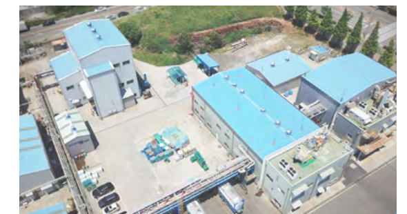
PO3G 생산설비 건설 중
