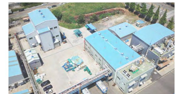
PO3G 생산설비 건설 중
